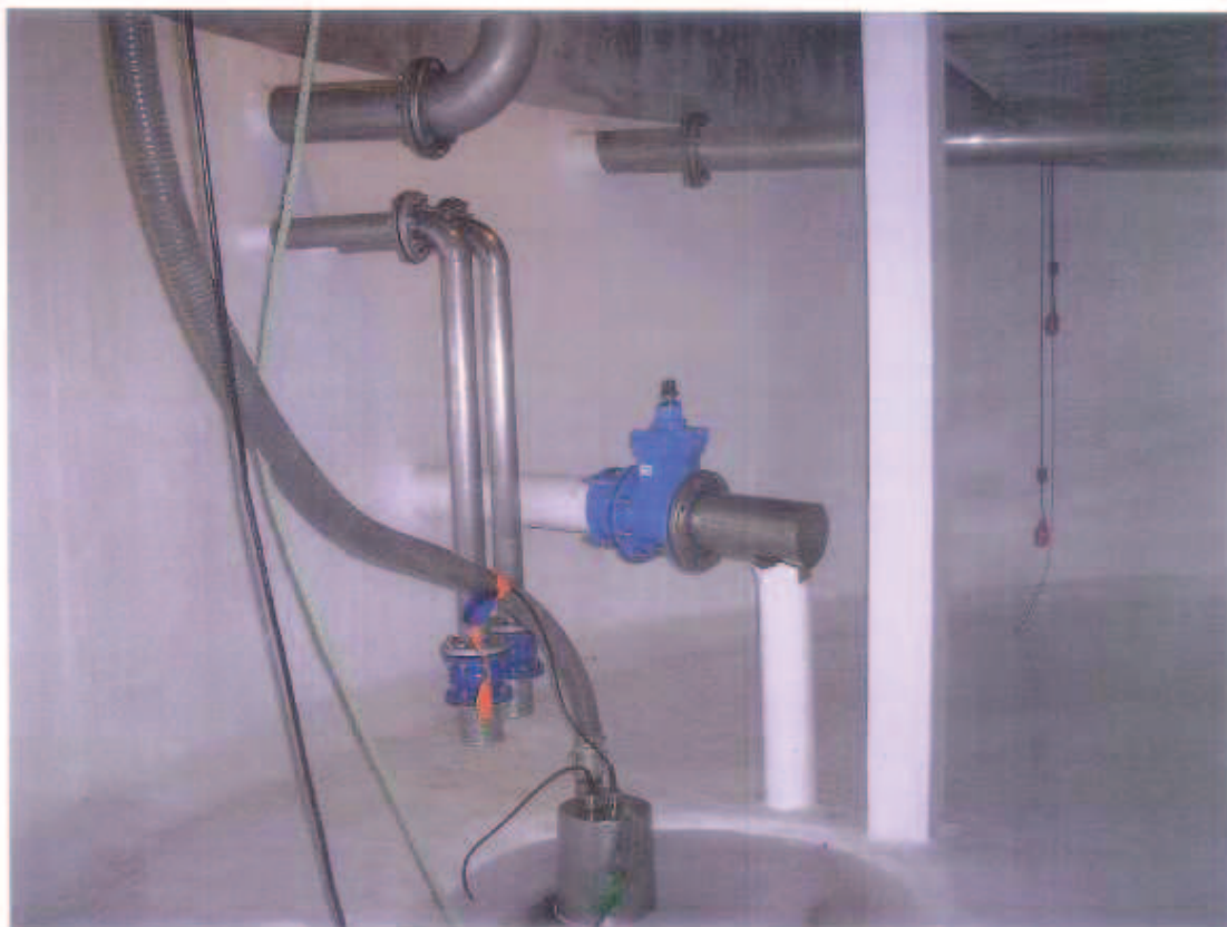
Schéma et photographies du réservoir avec les canalisations de raccordement du captage (cercle bleu) : « arrivée source par le bas + eau de source raccordée avec une bride ».
