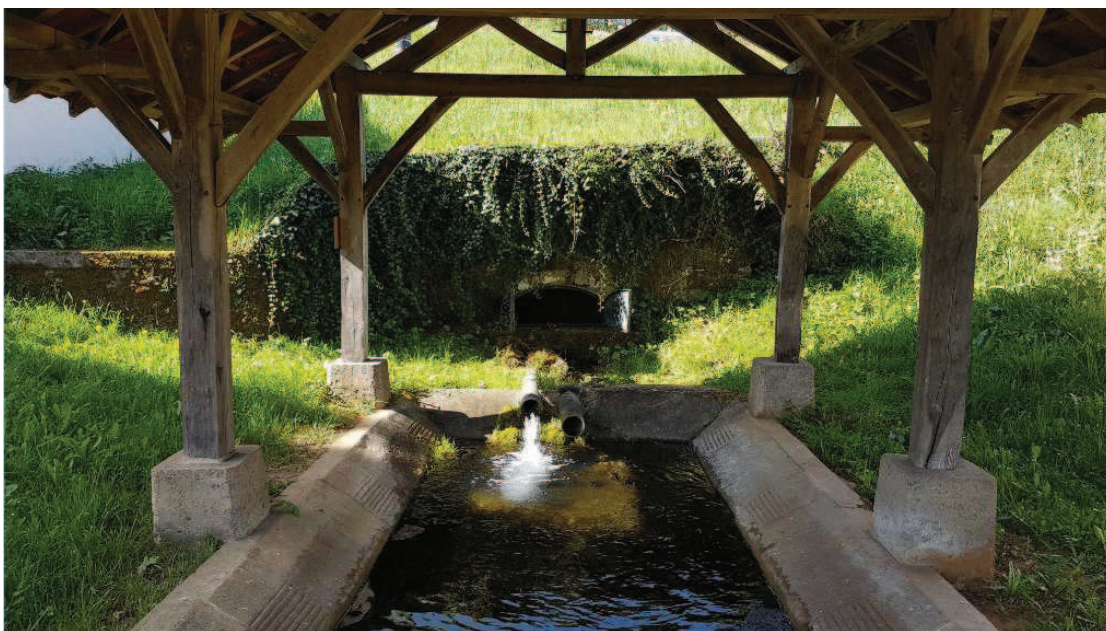
Lavoir et double canalisation d'alimentation du lavoir.
