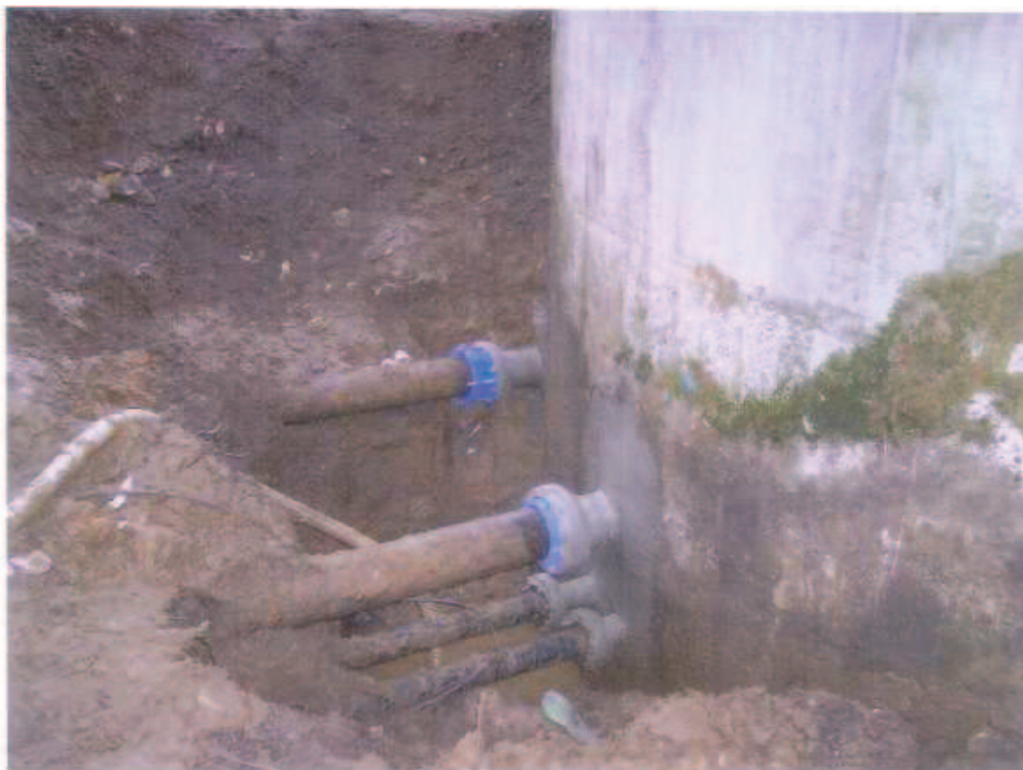
Vue des canalisations au moment des travaux sur le réservoir : canalisations d'aspiration et ?
